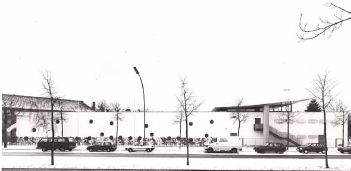
Abb.14 Lange Nordwand mit winzigen Bullaugen-Fenstern – für WC's / Duschen, Küchen und Wickelbereiche – schützt effizient vor dem Verkehrslärm der stark befahrenen Lindauer Allee!
