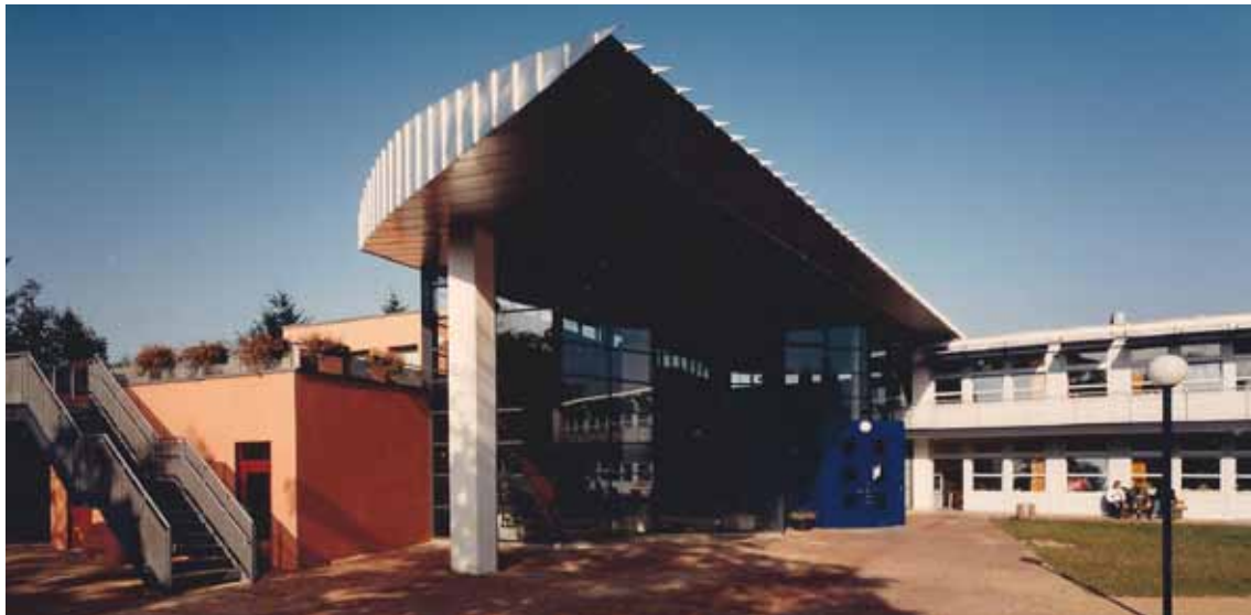
Abb.16 Das riesige Dach in Gestalt eines Flugzeugflügels schützt effizient vor dem Fluglärm der Einfugschneise Tegel direkt über dem Dach
