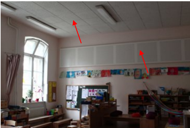
Bild 5: Akustikdecke und Wandfries in einem Klassenzimmer der Nürtingen GS
