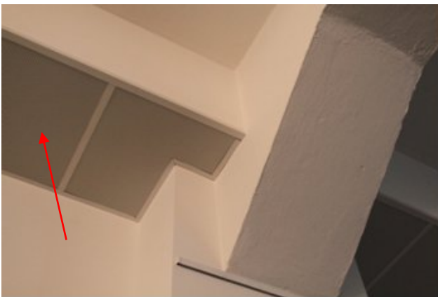
Bild 8: Kanten-Absorber im Pausenraum der MHMK
