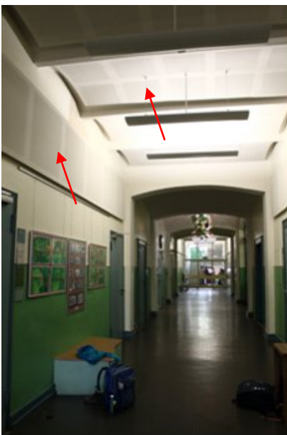
Bild 6: An Deckenwölbungen angepasste Absorbermodule und Wandfries in den Fluren der Nürtingen GS
